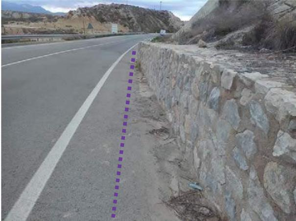
**DC. PK 0+500 b:** Zona de demolición y retranqueo de muro para alojar carril bici.
