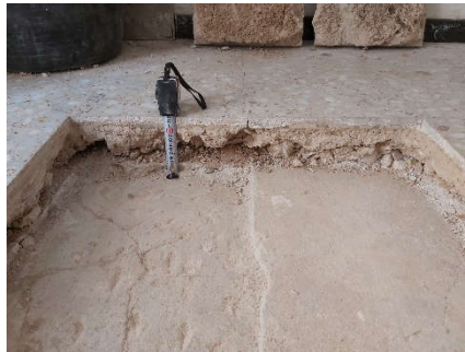
Detalle estratigrafía con pavimento de terrazo (2300), solera de cemento (2301) y suelos antiguos de yeso (2302, 2303)
