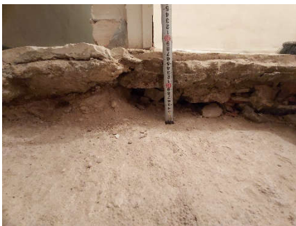
Detalle relleno (804 y 805)
