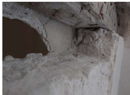
Detalle apoyo viga (1303) y muro de yeso (1304)
