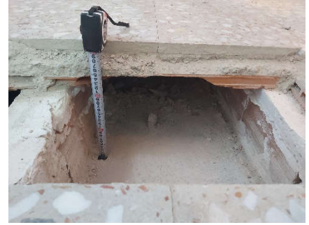
Detalle pavimento de terrazo (1400), baldas de ladrillo (1401), tabiquillos de ladrillo hueco (1403) y solera de cemento (1404)
