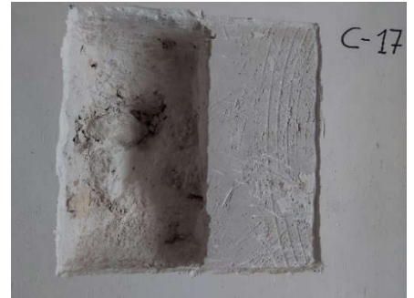
Detalle enlucido (1702) y muro (1703)
