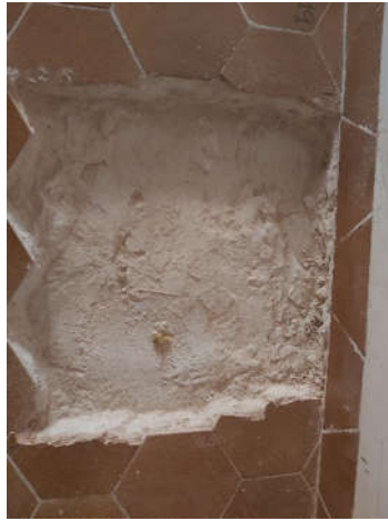
Vista general parte superior pilar (1902)
