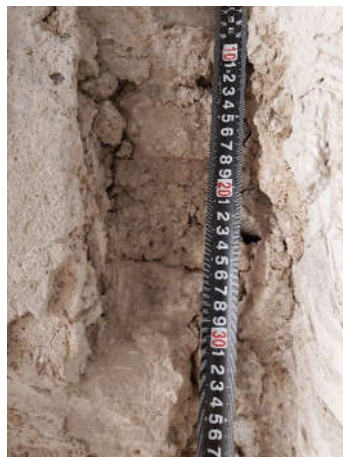
Detalle obra de tapial (507) con las tongadas de tierra y cal
