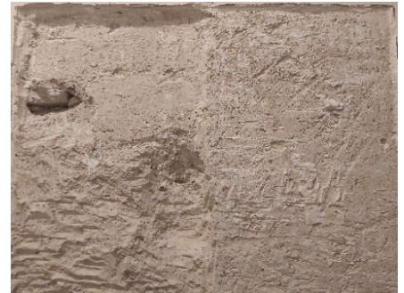
Detalle enlucido (701), muro (703) y reparación (705)
