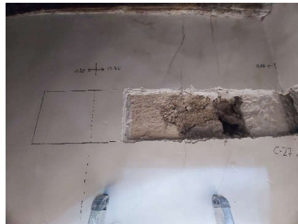
Vista general de la cata y de la ubicación del vano del grabado del siglo XIX
