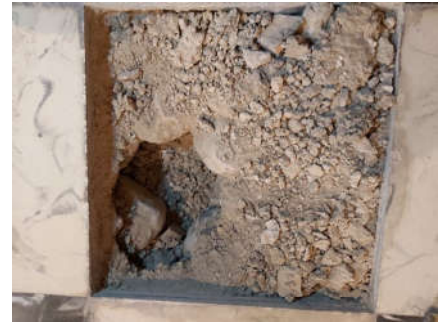
Detalle losa de hormigón con bolos (1102)
