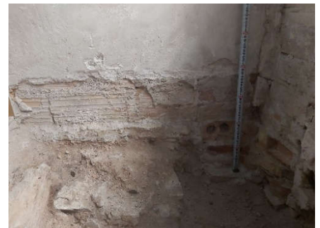
Detalle tabique moderno (2805)
