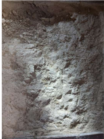
Detalle mortero de cal (2902)
