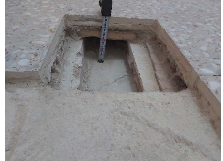
Detalle pavimento de terrazo (2200), baldas de ladrillo (2202) y tabiquillos de ladrillo hueco (2203)
