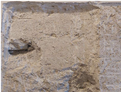
Detalle muro (703) enlucido
