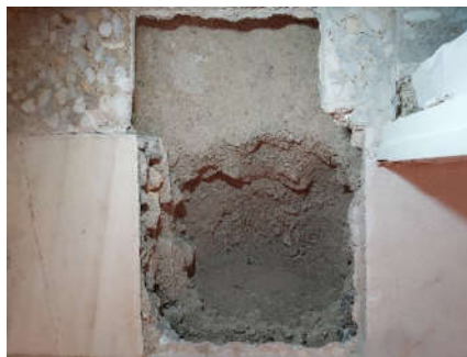
Vista general excavación relleno de tierra (806)
