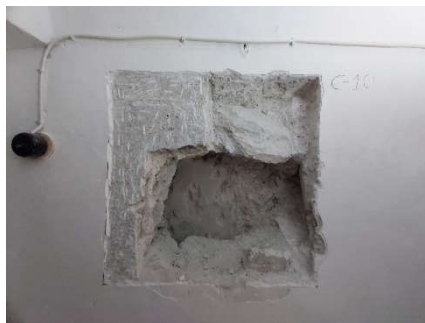
Vista general forro (1003) y muro de la iglesia (1004)
