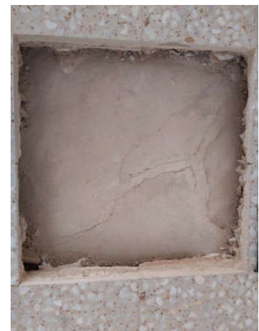
Detalle suelo antiguo de yeso (2204)
