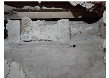
Detalle alfarje (2604) jaldetas y obra (2605) entre ellas
