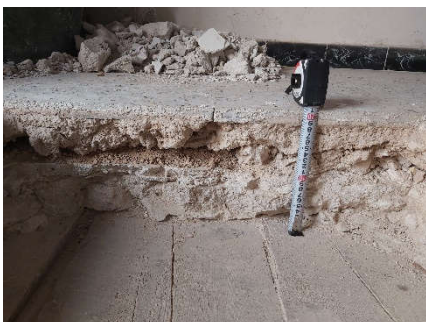
Detalle estratigrafía con pavimento de terrazo (2300), solera de cemento (2301), suelos antiguos de yeso (2302, 2303) y alfarje (2304)
