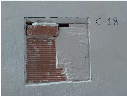
Detalle enfoscado (1801) y tabique de ladrillo (1802)
