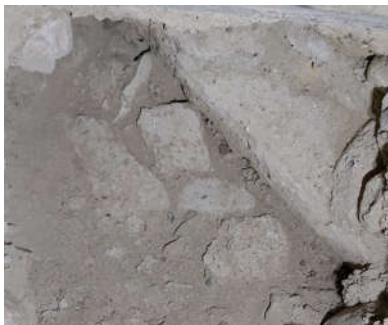
Detalle muro (1103) y relleno (1104)
