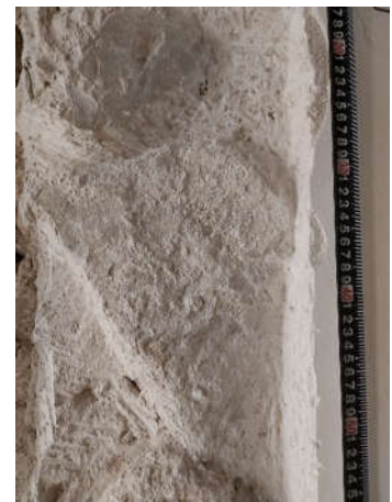
Detalle obra de mampostería (506)
