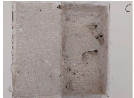
Detalle enfoscado (3102) y mampostería (3103)
