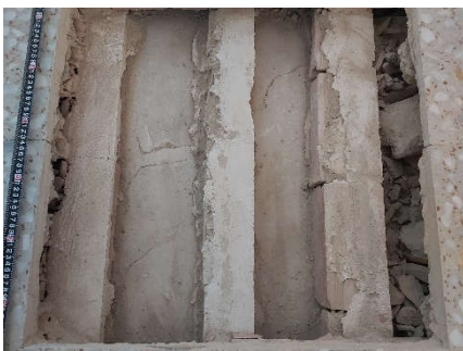
Detalle tabiquillos de ladrillo hueco (2203)
