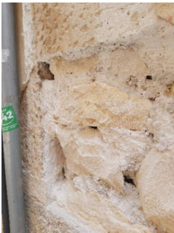
Detalle enfoscado (901) sobre muro de mampostería (902)
