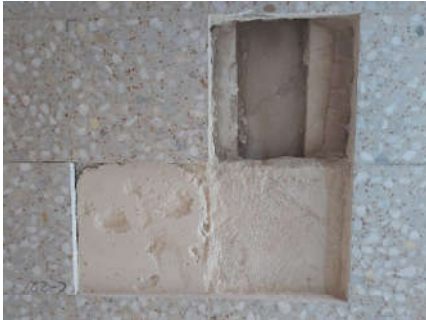
Vista general cata con pavimento de terrazo (2200), solera de cemento (2201) y tabiquillos de ladrillo hueco (2203)
