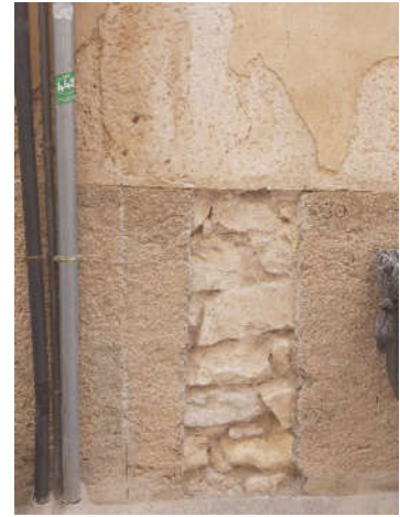
Detalle muro de fachada de mampostería (3001) y en la parte superior, enlucido (900) y enfoscado (901)
