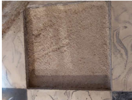
Detalle solera de cemento (1201)
