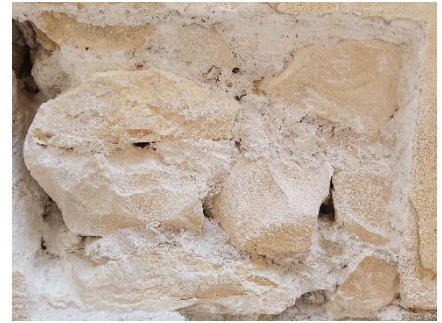
Detalle muro de fachada de mampostería (902)
