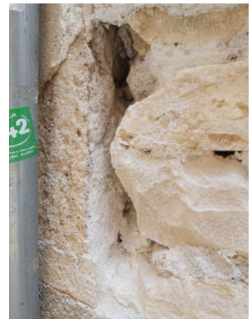
Detalle grosor enfoscado (901) sobre muro de mampostería (902)
