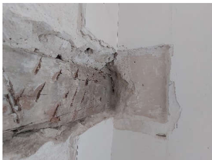
Detalle viga (1303) embutida en el muro original del convento (1307) con sucesivos enlucidos (1308, 1309, 1310)
