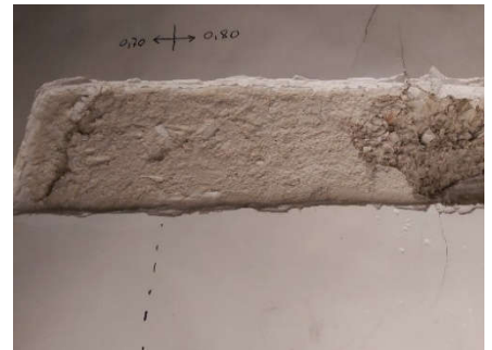
Detalle de la zona de ubicación del vano del grabado del siglo XIX ocupado por el muro de tapial (2705)
