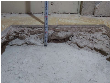
Detalle estratigrafía cata, pavimento losas (1500), solera cemento (1501), rellenos (1502, 1503) y solera de cal (1504)
