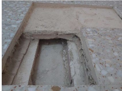
Detalle pavimento de terrazo (2200), solera de cemento (2201), baldas de ladrillo (2202) y tabiquillos de ladrillo hueco (2203)
