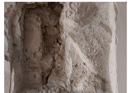
Detalle de los dos tipos de fábrica mampostería (506) y tapial (507)
