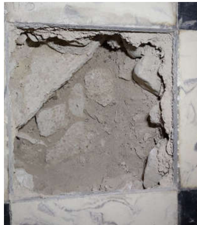
Detalle muro (1103) y relleno (1104)
