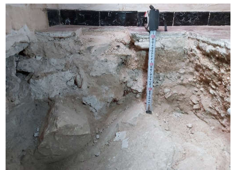
Detalle secuencia estratigráfica suelo hidráulico (2900), mortero de cal (2902), rezarpa (2904), relleno (2903) y roca de base (2906)
