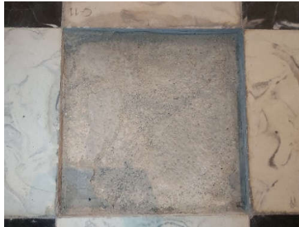
Detalle solera de cemento (1101)
