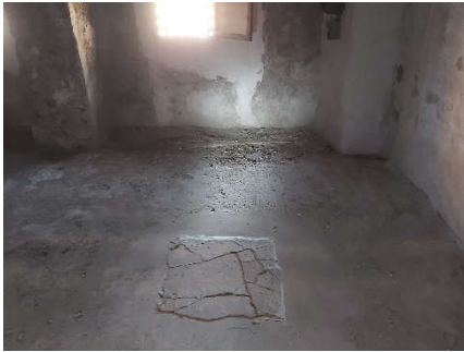
Vista general cata en bajo-cubierta
