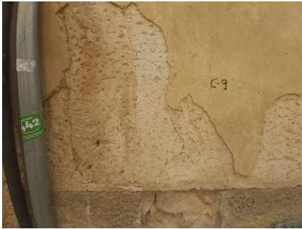
Vista general enlucido (900) y enfoscado (901)
