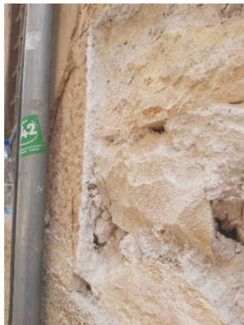
Detalle enfoscado (901) sobre muro de mampostería (902)
