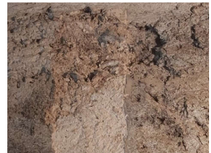
Detalle ampliación cata enfoscado (201) y muro de tapial (203)
