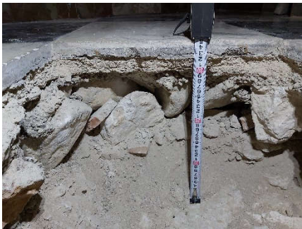
Detalle perfil estratigráfico pavimento de losas en damero (1100), solera de cemento (1101) y losa de hormigón (1102)
