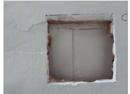
Detalle pared de azulejo (1803)
