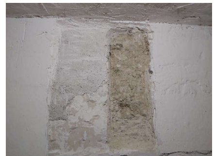
Detalle fábrica de tapial (305)
