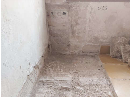
Vista general después de levantar el suelo hidráulico (600)
