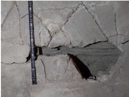
Vista general cata en bajo-cubierta, Suelo de yeso (2601) y alfarje (2604)
