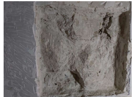
Detalle fábrica de mampostería (304)
