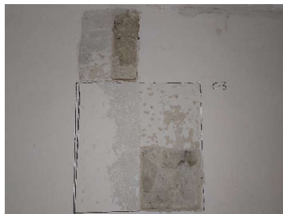
Vista general ampliación cata en la parte superior, enlucidos (301, 302) y enfoscado (303) y obra de mampostería (304) (zona inferior) y tapial (305) (zona superior)
