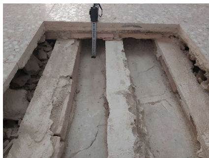
Detalle pavimento de terrazo (2200), baldas de ladrillo (2202) y tabiquillos de ladrillo hueco (2203)
