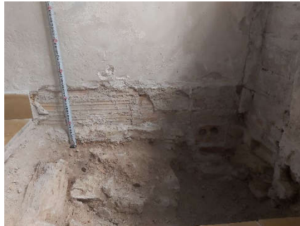
Detalle forjado colaña (603) y revoltón (606) y mocheta (604) sobre los que apoya un tabique moderno de ladrillo hueco
