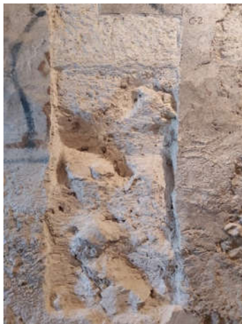
Detalle muro de mampostería (202)
