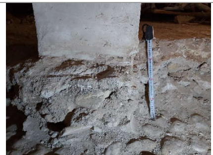
Detalle cimentación (111) pilar (110)
