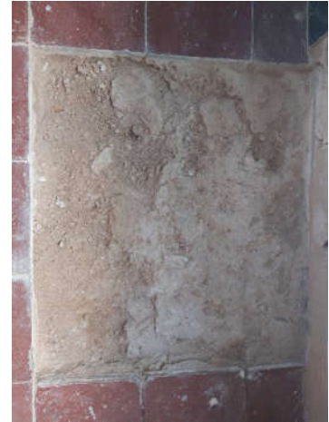
Vista general mortero de cal (2902) y relleno (2903)
