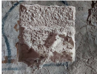
Detalle enfoscado (201) y muro de mampostería (202)
