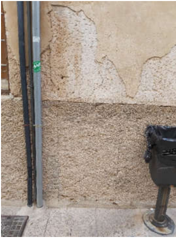
Vista general zócalo con enlucido de cemento (3000), enlucido (900) y enfoscado (901)
