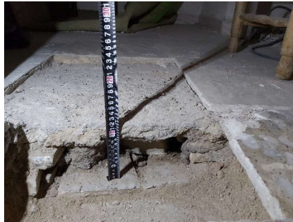
Detalle relleno (804) bajo solera (803) y losas de mármol (800)
