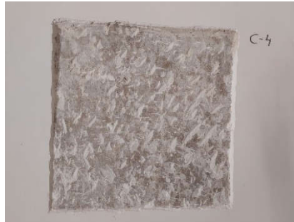
Vista general enfoscado (403)
