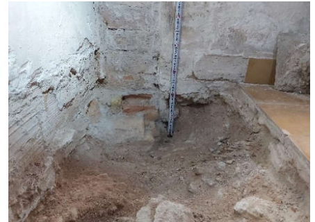
Detalle forjado colaña (603) y mocheta (604)
