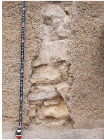
Detalle muro de fachada de mampostería (3001)
