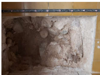
Detalle forjado colaña (603) y revoltón (606)
