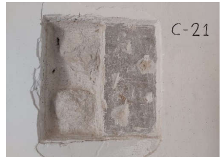
Detalle enlucido (2103) y muro (2106)
