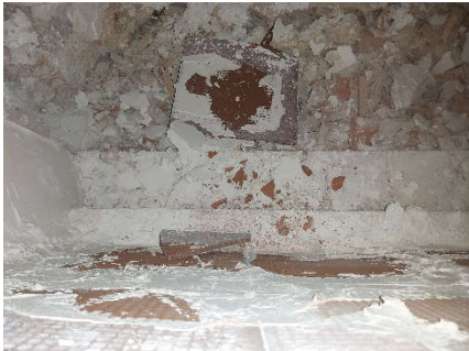
Detalle interior cámara hueca (1804) cerramiento con azulejo (1803)
