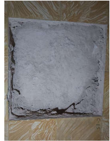
Detalle solera de cal (1504)
