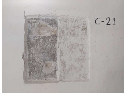
Vista general enlucidos (2102, 2103)
