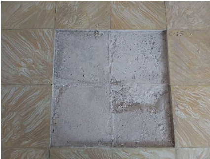
Vista general cata con pavimento de losa veteadada hidráulica (1500) y solera de cemento (1501)
