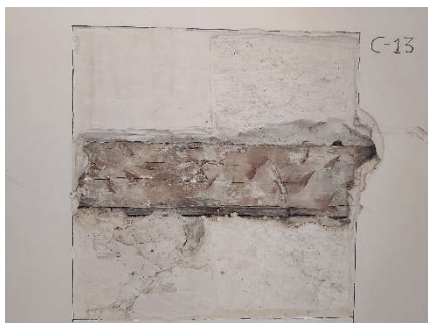
Vista general enlucidos (1300, 1301, 1302), muro de yeso (1304) y viga (1303)
