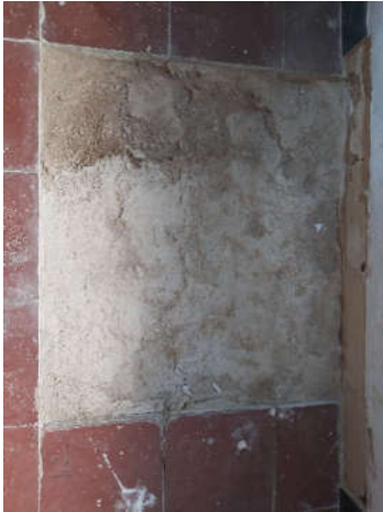
Vista general después de levantar el suelo hidráulico (2900), mortero de cal (2902)
