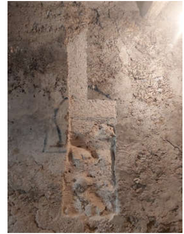
Vista general ampliación cata enfoscado (201) y muro de mampostería (202)
