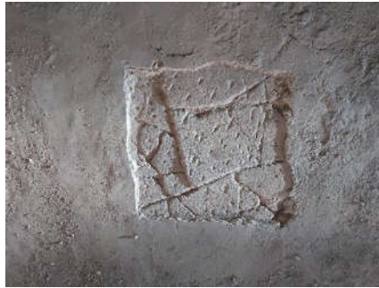
Detalle suelo antiguo de yeso (2502)
