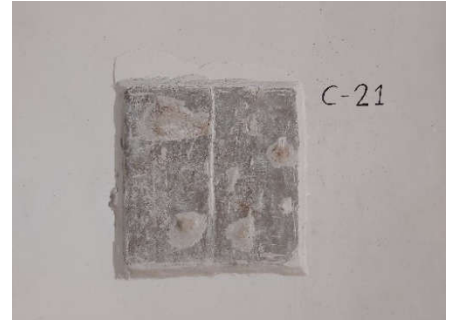
Vista general enlucidos (2103)
