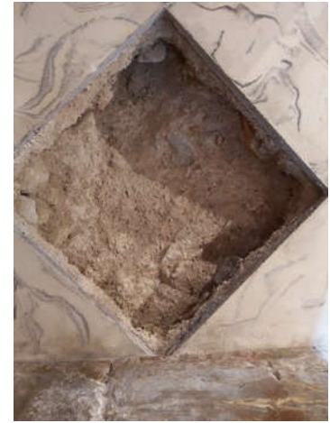
Detalle muro de la iglesia (1203)
