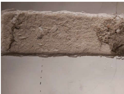
Detalle muro de tapial (2705)
