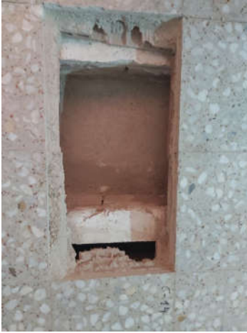
Vista general cata con pavimento de terrazo (1400) y tabiquillos de ladrillo hueco (1403)
