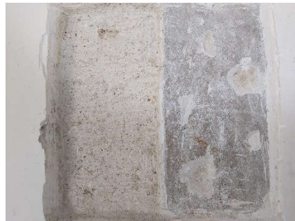
Detalle enlucido (2103) y enfoscado (2105)
