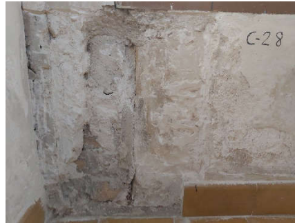
Detalle de la jamba (2802) y enfoscado (2801)
