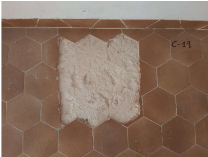
Vista general pavimento (1900) y solera de cemento (1901)
