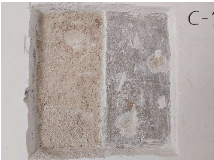
Detalle enlucido (2103) y enfoscado (2104)
