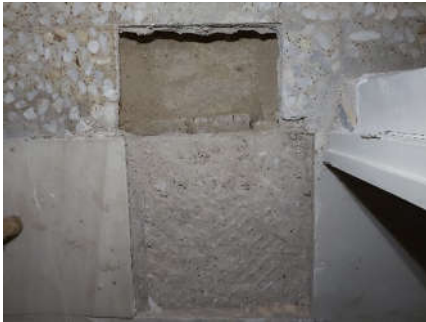
Vista general cata situada entre el pasillo de acceso a la iglesia y el confesionario. Solera (803) de cemento para la losa de mármol (800)
