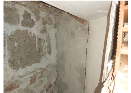
Detalle vano (1805) cámara hueca (1804), tabique ladrillo (1806) y recrecido tabique con losa de terrazo (1807)
