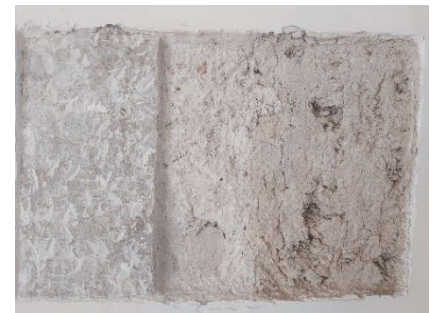
Detalle enfoscado (403), fábrica de mortero de cal en masa con piedra (406) en la zona central y de tapial (404) a la derecha
