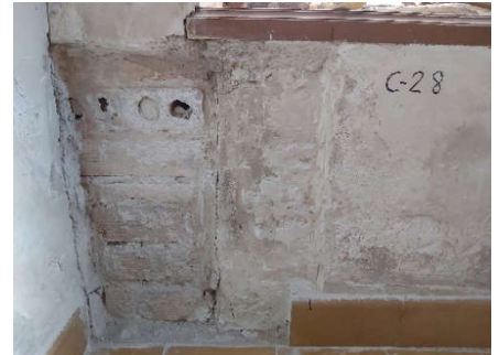
Detalle de la jamba (2802), murete de cerramiento (2803) del vano (2804)
