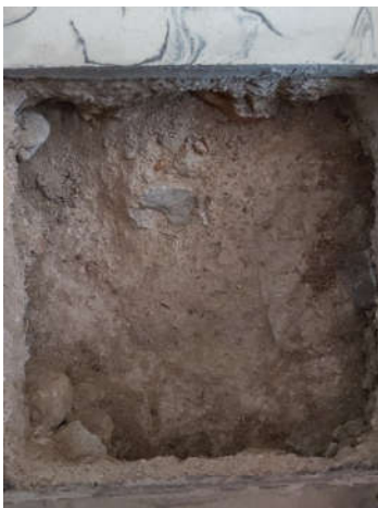
Detalle tipo de fabrica del muro de la iglesia (1203)
