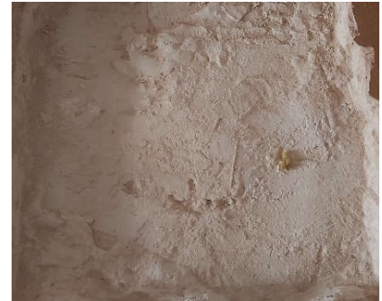
Detalle obra pilar (1902)
