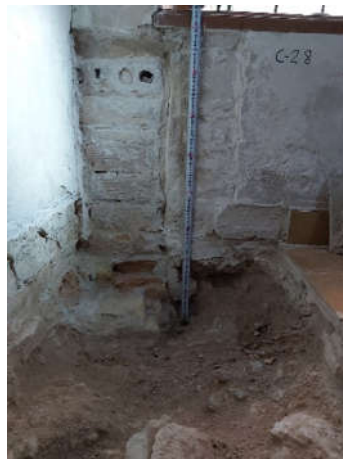
Detalle jamba (2802) y murete de cerramiento (2803) del vano (2804)
