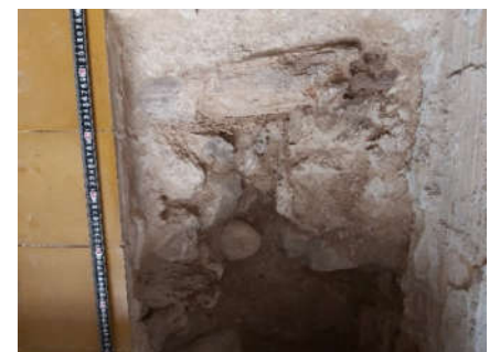
Detalle forjado colaña (603) y revoltón (606)
