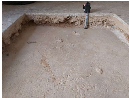
Detalle estratigrafía con pavimento de terrazo (2300), solera de cemento (2301) y suelo antiguo de yeso (2302)
