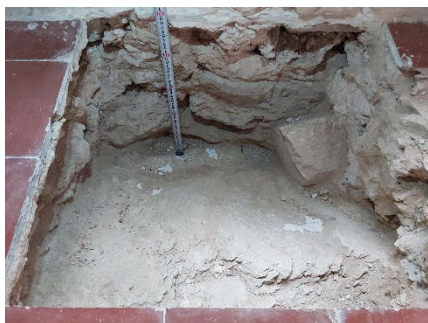
Detalle diferentes niveles de amortización del vano (2904, 2905, 2907)
