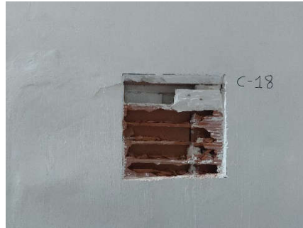
Detalle tabique de ladrillo (1802)
