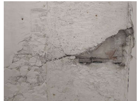
Detalle muro de yeso (1304) y viga de madera (1303)
