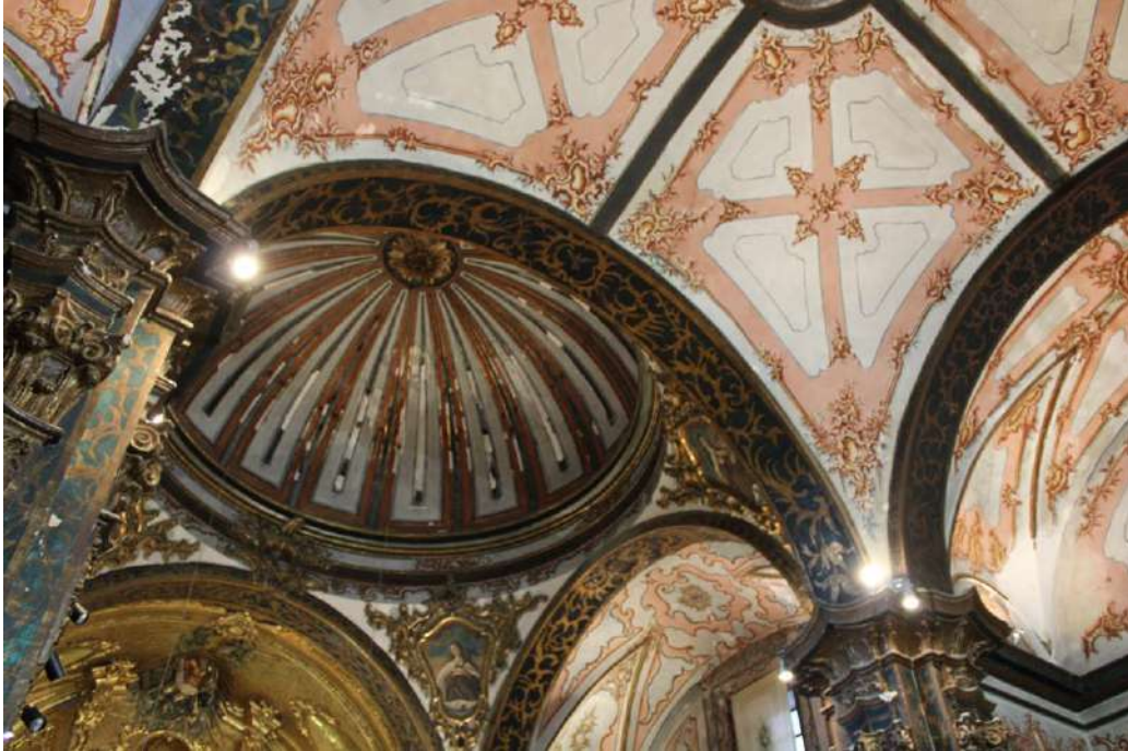
Figura 14; Cúpula sobre pechinas, detalle de la bóveda vaída y de las bóvedas de cañón de la capilla lateral del lado de la epístola
