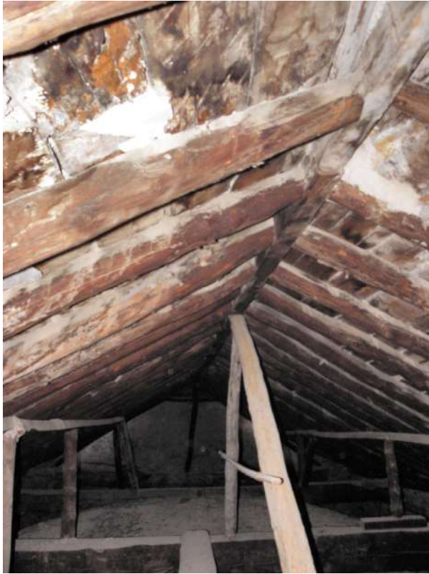
Fotografía 42: Bajo cubierta de la iglesia
