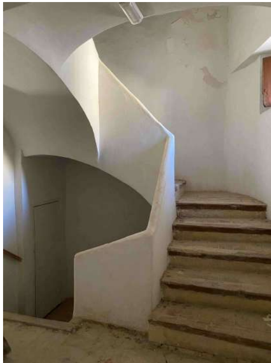
Fotografía 19: Escalera del convento
