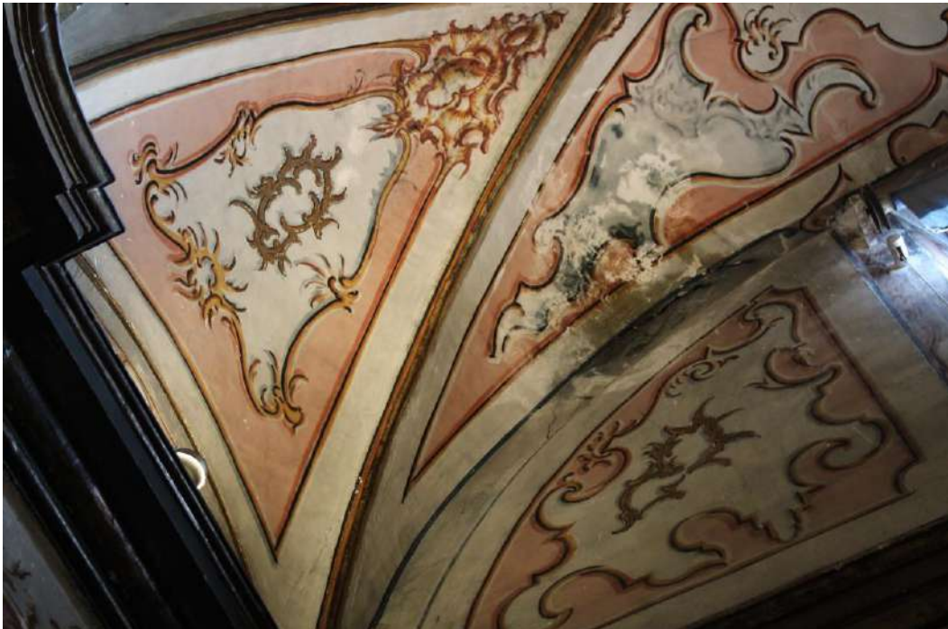
Figura 15; Bóveda de unas de las capillas laterales de la iglesia
