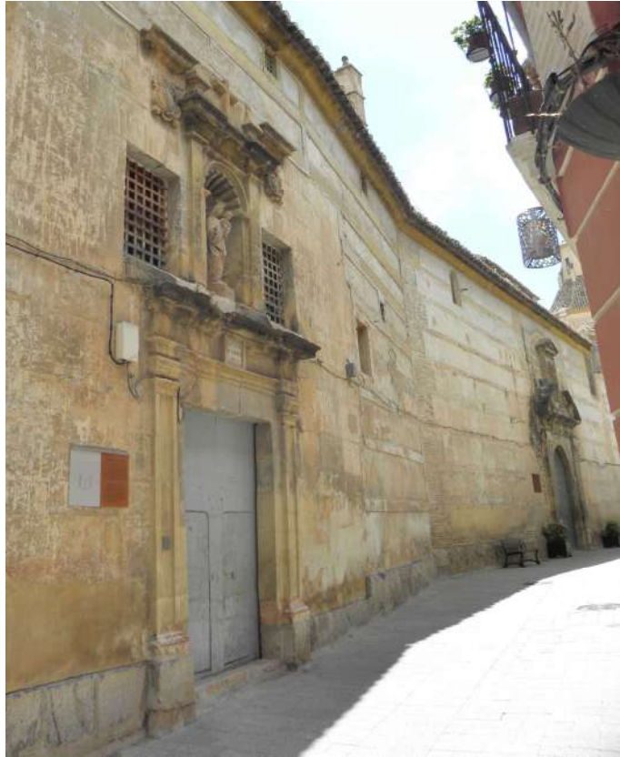
Fotografía 01: Exterior. Casa Fundacional e iglesia de san José
