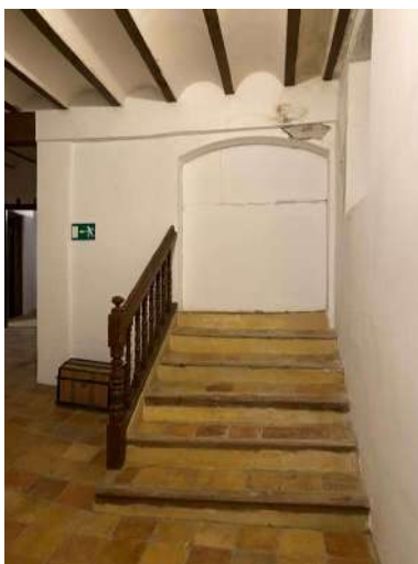
Fotografía 21: Antepostería. Escalera del convento
