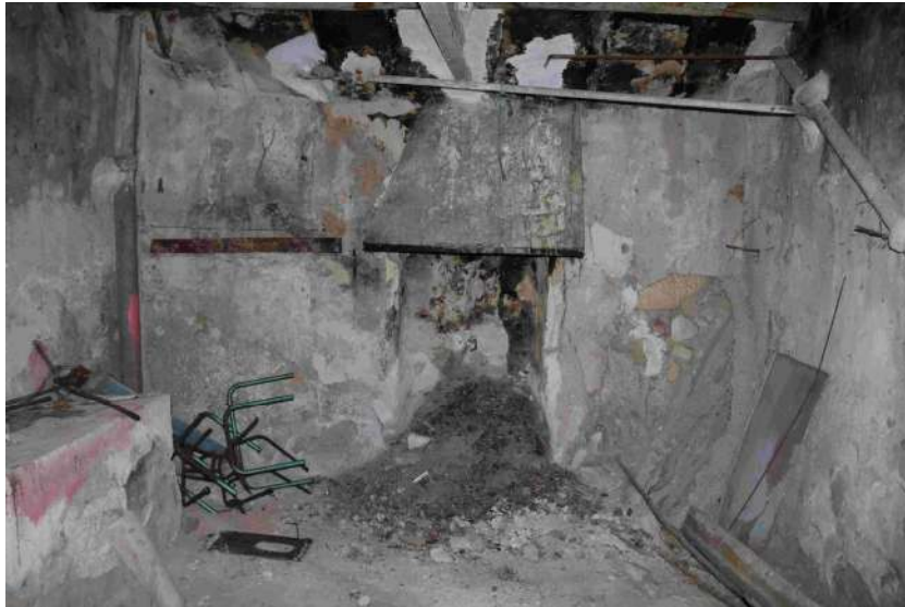
Fotografía 28: Casa de la Mandadera. Cocina del sótano
