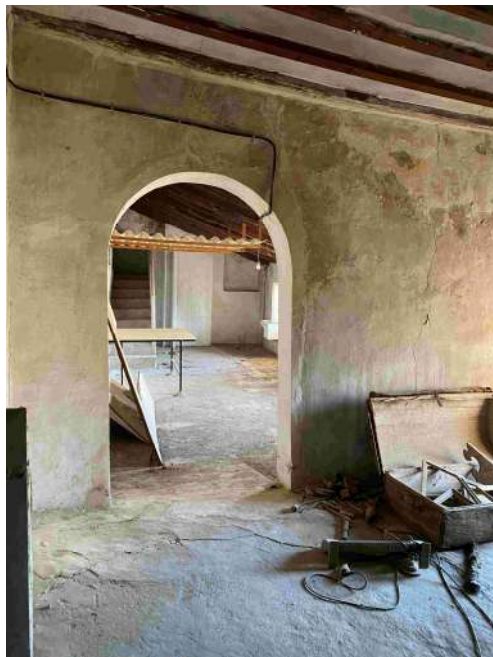
Fotografía 38: Sala 1 de la planta superior de la Casa Fundacional y conexión con la planta superior de la Casa de la Mandadera
