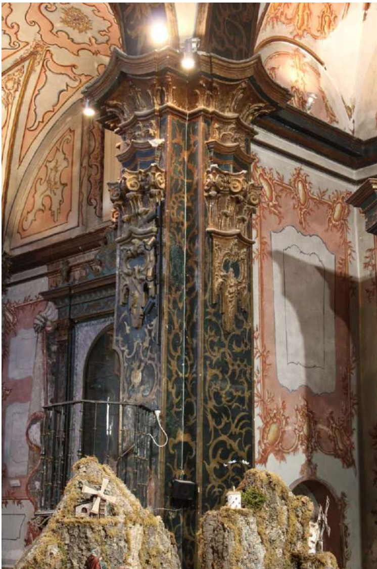
Figura 28; Ejemplo de fotografías iniciales de una pilastra del interior de la iglesia de San José. Carmelitas de Caravaca de la Cruz. Murcia
