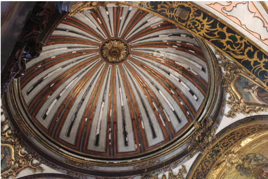
Figura 29; Cúpula sobre pechinas de la iglesia de San José. Convento de Carmelitas de Caravaca
