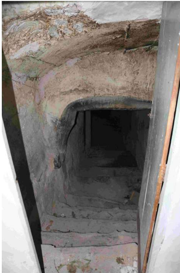
Fotografía 30: Casa de la Mandadera. Escalera de bajada al sótano
