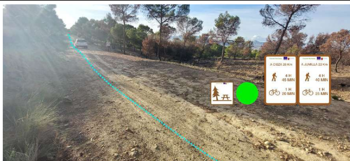
PK 46+800a. Lugar donde se proyecta el área de descanso 10, A10: Umbría Sierra Larga 2 y por ello, se utiliza señal tipo I-10 (Señal de existencia de áreas de descanso). Señales tipo I50- indicando la distancia a la que se encuentra el usuario.
