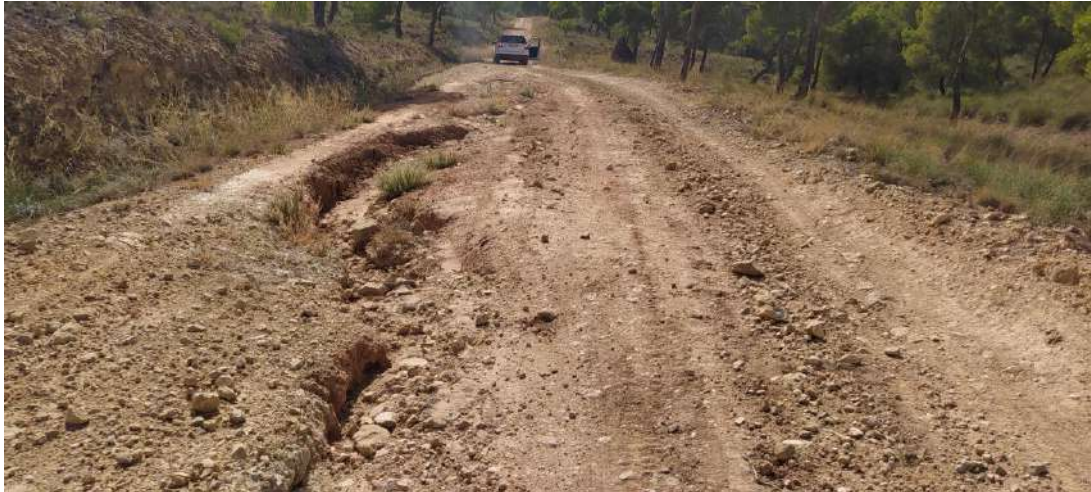
Fotografía 2. Tramo con reguero de cierta entidad sobre pista forestal de Sierra Larga
