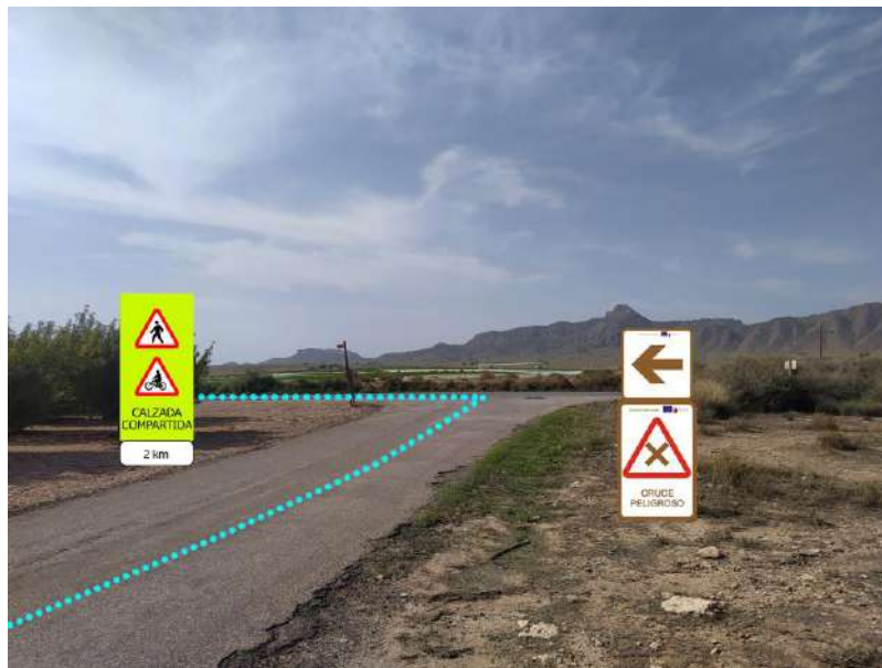
PK 54+500a. Señal D13-i, flecha direccional marcando el sentido del recorrido, junto con señal PR-9, señal preventiva por cruce peligroso en ambos lados de la carretera. Colocación de cartel de precaución para vehículos por calzada compartida con peatones y ciclistas, tramo compartido de 2Km.
