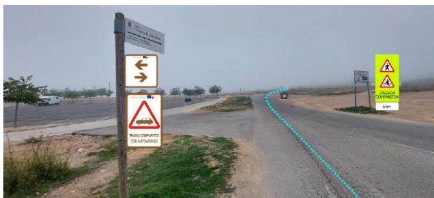
PK 01+880a. Sobre poste de madera existente, colocación de señal bidireccional D13 junto con señal preventiva de tramo compartido con automóviles (PR-15). Calzada compartida durante un recorrido de aproximadamente 6 Km, colocación de cartel de precaución para vehículos por calzada compartida con peatones y ciclistas.
