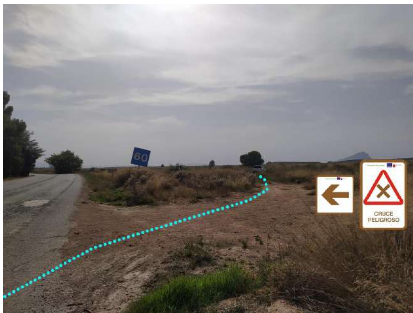
PK 54+860a. Señal D13-i, flecha direccional marcando el sentido del recorrido, junto con señal PR-9, señal preventiva por cruce peligroso en ambos lados de la carretera.
