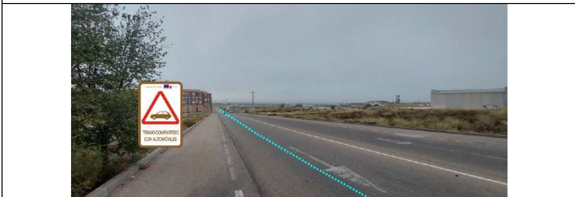
PK 01+210a. Ubicación de señal preventiva por tramo compartido con automóviles, señal PR-15.
