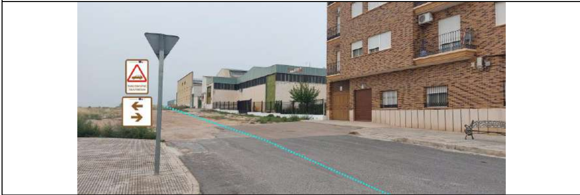
PK 00+560a. Ubicación de Señal D-13 y PR-15, ambas sobre poste de madera. Indicación de inicio de tramo compartido con automóviles.
