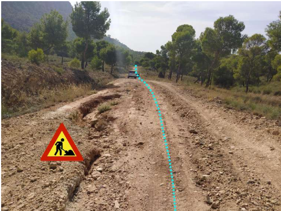
PK 48+220a. Señal TP-18, obras.
