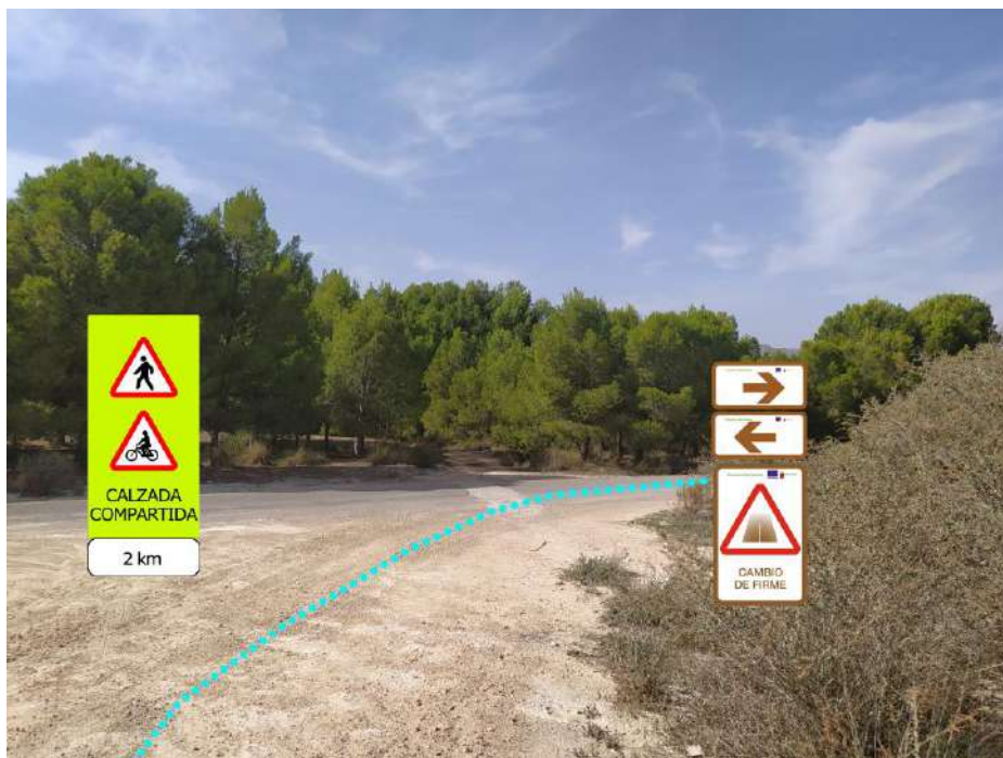
PK 52+500a. Señal PR-11, indica prevención por cambio de firme, junto con señales con flechas direccionales tipo CC-1 y CC-2. Así como en la parte izquierda, cartel de precaución para vehículos por calzada compartida con peatones y ciclistas, durante un tramo compartido de 2Km.
