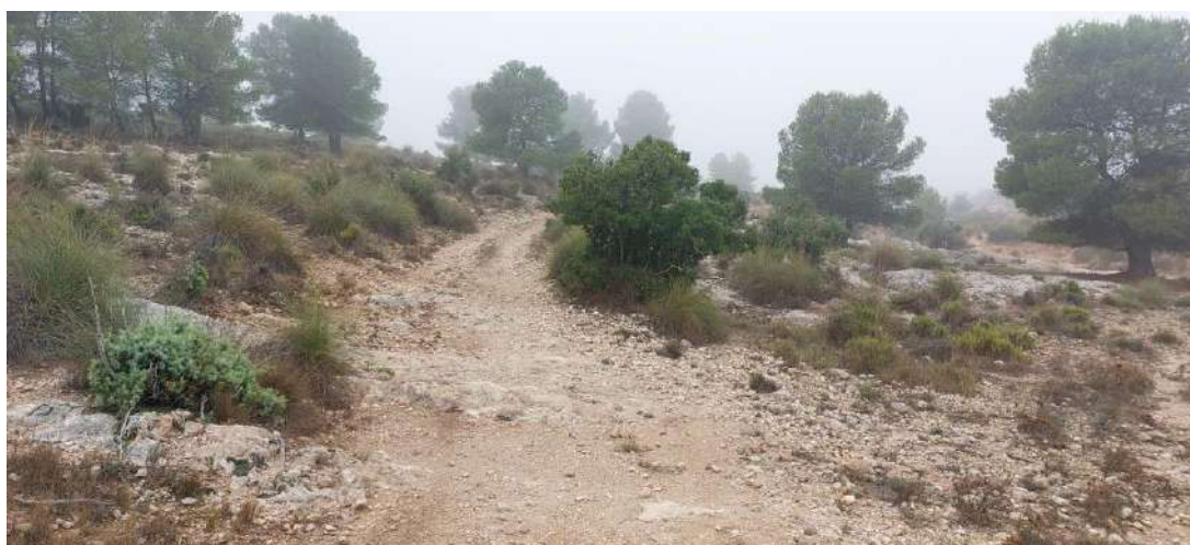
Fotografía 1. Tramo de grava suelta, incluso betas de roca caliza, PK
