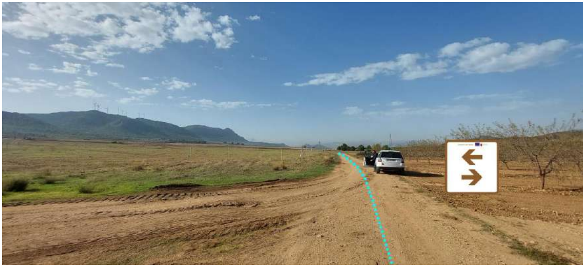
PK 16+380a. Señal bidireccional tipo D13 sobre poste madera, indicando la dirección del recorrido.
