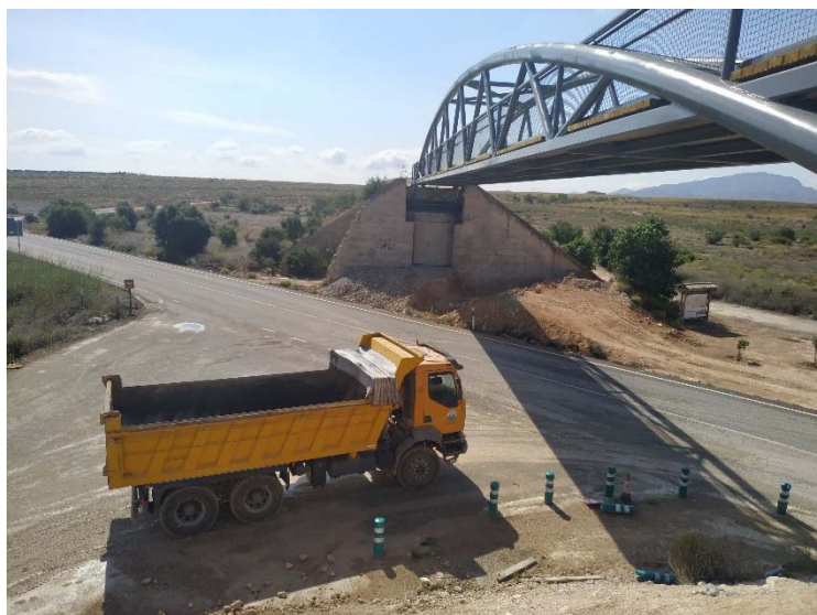
Pasarela peatonal para cruce con la carretera RM-E11
