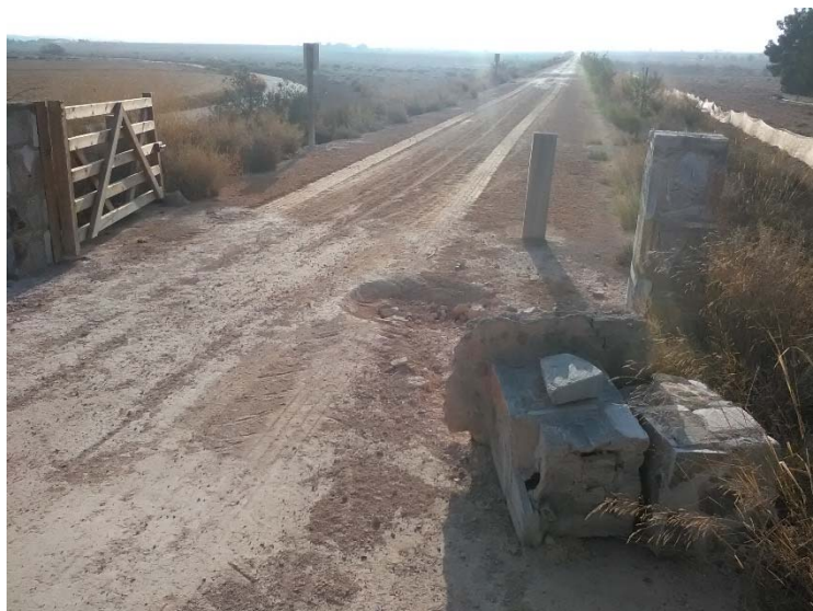
DC. PK 9+900: Situación de la plataforma de la Vía Verde de Cartagena, con una de sus puertas a reconstruir.
