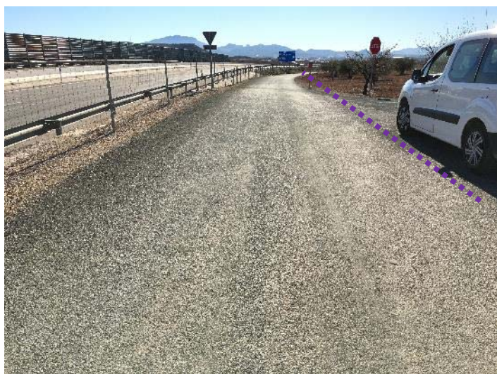
DC PK 12+800: Cruce de la Vía Verde con la carretera RM-23, MD, trazado por la Vía de servicio de la misma carretera.
