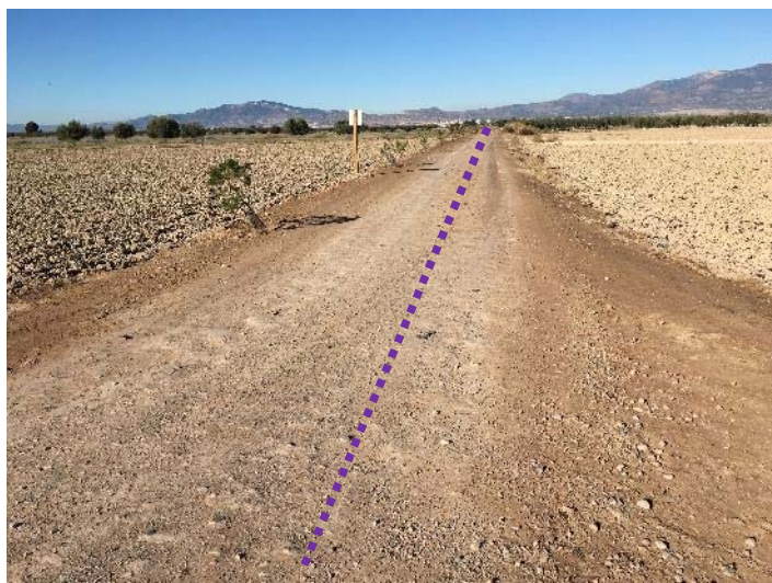
DC PK 7+200: Inicio de tramo en tierras. Ejecución de acondicionamiento superficial de plataforma y limpieza de cunetas.
