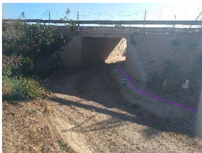
DC y DT PK 50+775: Paso de Vía Verde bajo autopista AP-7.
