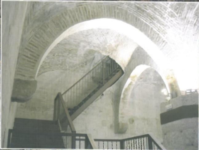
El edificio que ha llegado hasta nosotros es el original, a excepción del remate (pretil y almenas). Tiene planta cuadrada (12'90 m de lado) y alcanzó una altura aproximada de 21 m. Sus muros son tapias de mortero de cal de 1'60 m de espesor.
